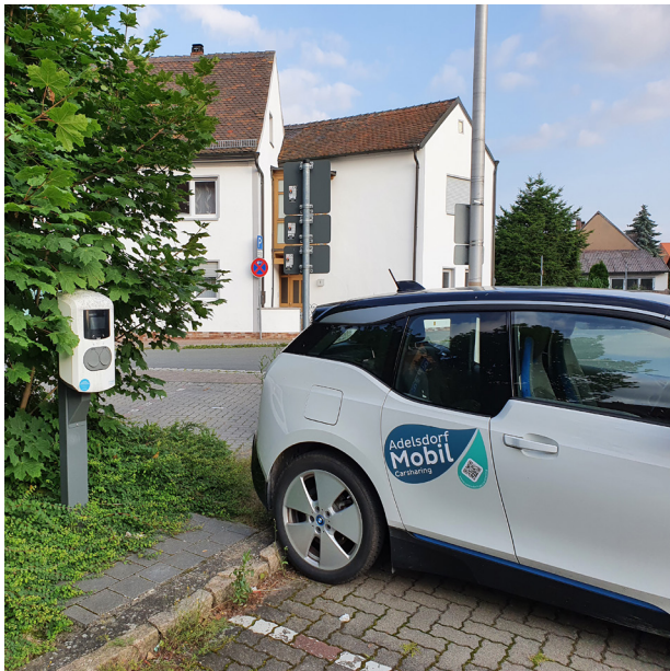
Abbildung 10: E-Ladestation mit gemeindeeigenem Carsharing-Auto
