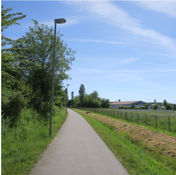
Abbildung 5: Beleuchteter Radweg am westlichen Rand der Läusbergsiedlung (im „Grünen“)
